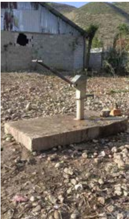
Fig. 3 — Pompe installée sur un terrain rocheux, illustrant les contraintes d'implantation
