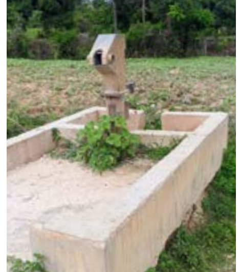
Fig. 2 — Pompe communautaire non fonctionnelle, envahie par la végétation
