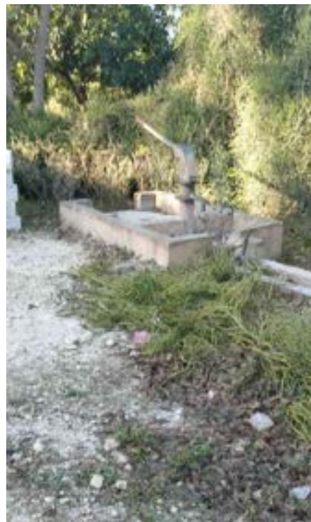
Fig. 4 — Pompe abandonnée et détériorée
